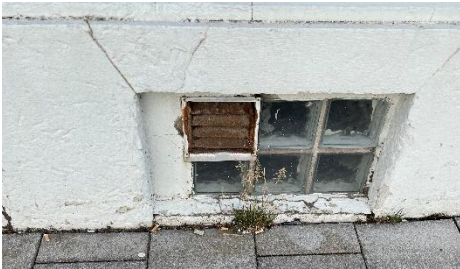
Figur 11. Fönster samt ventil för befintlig byggnads källarutrymme.
