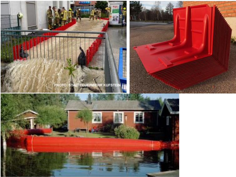
Figur 14. Exempel på mobila översvämningsskydd. Bilderna överst visar monterbar skyddsvall medan den nedre bilden visar en uppblåsbar skyddsvall. Källa: NOAQ.
